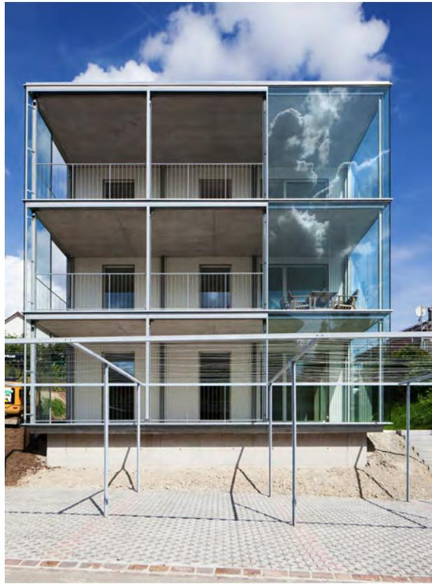
Konstruktiv ist das kleine Mehrfamilienhaus als Hybridbau ausgeführt: Der Keller, alle Decken, das Dach und die Treppenhauswände wurden in Ortbeton ausgeführt, die Aussenwände in Holzrahmen-Element- und alle Zimmertrennwände in Leichtbauweise. Zum Innenraum wurden die Fassadenelemente mit einer sichtbaren raumhohen Birkenperrholzplatte verkleidet.
